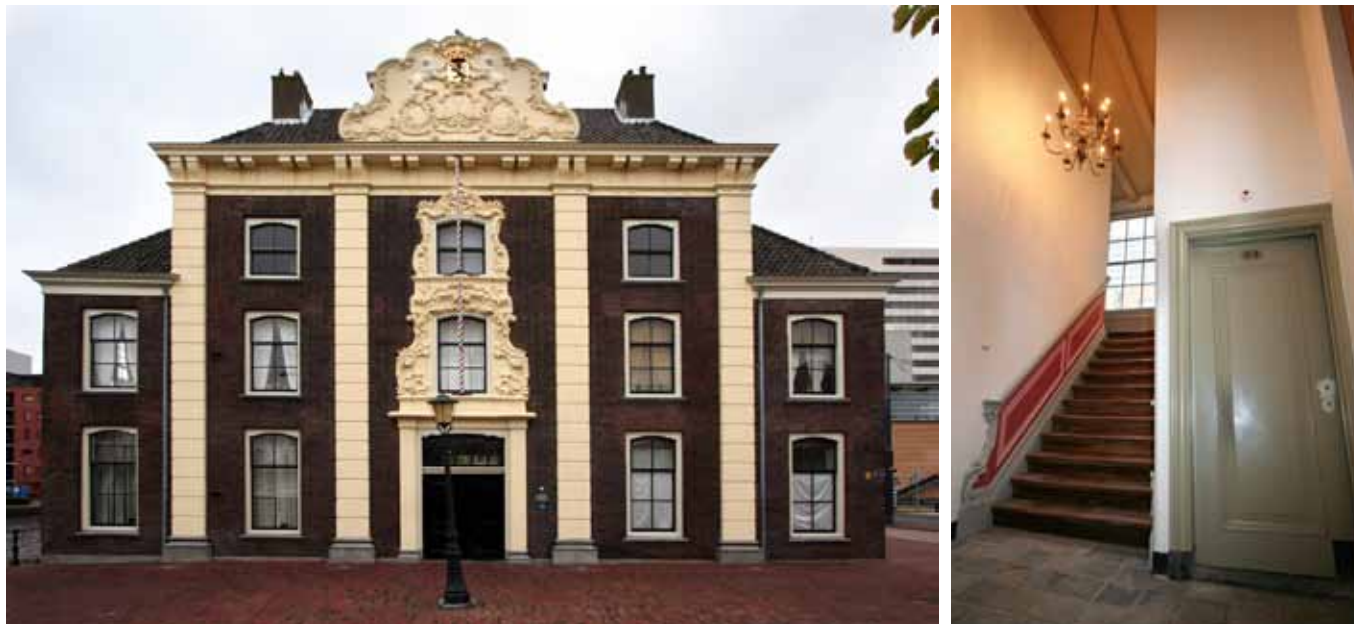
De nieuwe woningen volgen de structuur van het dak, dat uit drie kappen bestaat.
